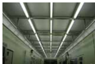
層流型クリーンルーム設備
