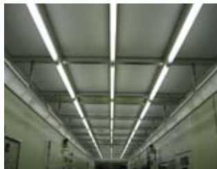
層流型クリーンルーム設備
