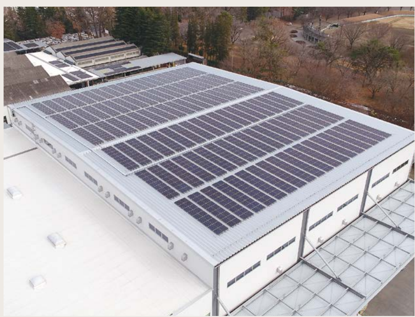
工場建屋に設置された太陽光パネル
