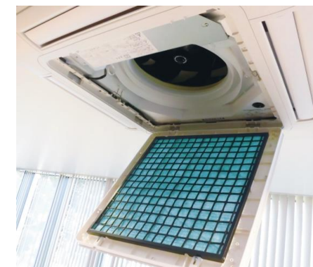
酵素フィルターをてんかせ4方向に組み込んだ写真
