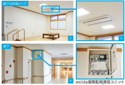
1 入居者様がくつろぐ1階のリビングには、「てんかせ4方向」を採用。2 3 廊下にある量が数かれた和室エリアの頭上には、「てんかせ2方向」を配置。4 壁の高い位置に設置された据置タイプの「exiida 遠隔監視通信ユニット」で施設内の空調機器を常時監視。5 施設の屋上に設置されたビル用マルチエアコン「フレックスマルチ」。6 店舗・オフィス用パッケージエアコン「省エネの達人プレミアム」を1階に設置。
