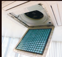
酵素フィルターを組み込んだ写真 (てんかせ4方向、てんつりの場合)
