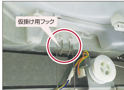
写真は昇降グリル付きパネル取付け時
