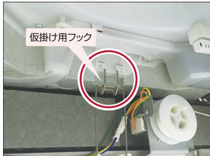
写真は昇降グリル付きパネル取り付け時
