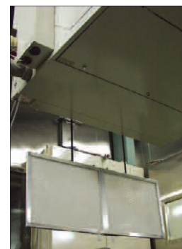
昇降フィルターでメンテナンスが容易。
