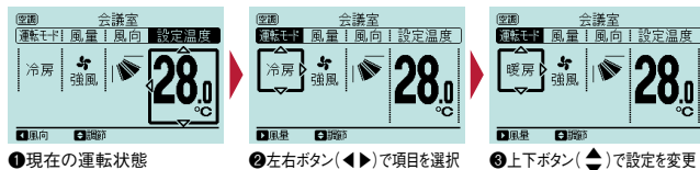
①現在の運転状態
