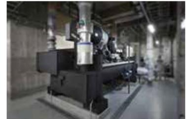
6 熱回収型ターボ冷凍機 HC-F10B35SV-SV
