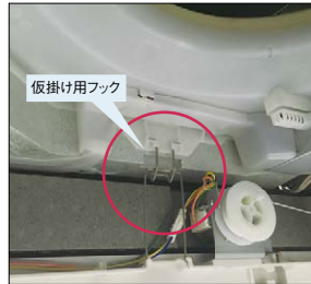
写真は昇降グリル付きパネル取付け時
