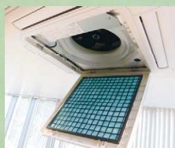
酵素フィルターを組み込んだ写真 (てんかせ4方向、てんつりの場合)
