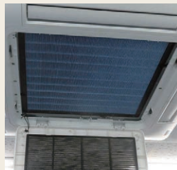
抗菌加工高性能フィルターを てんかせ4方向に取り付けた写真
