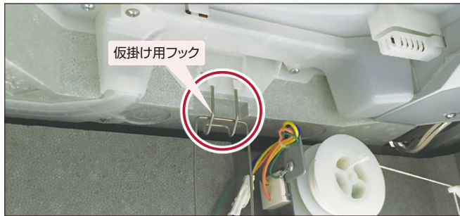
写真は昇降グリル付きパネル取付け時
