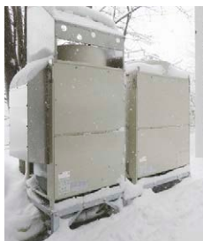
■フィールド評価機 寒さ知らず: RAS-AP280DN 標準機: RAS-AP280DS5
