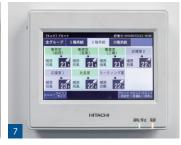
1 2 工期短縮と省エネ効果を考えて、既設配管を利用できるビル用マルチエアコン「フレックスマルチ リニューアル型(高効率タイプ)」を中心に採用。 同じく省エネ効果の高い店舗・オフィス用パッケージエアコン「省エネの達人プレミアム (R32機)」と共に屋上に設置。3 4 5 2階の事務所には 「てんかせ4方向」、同じく2階の応接室には「てんかせ1方向」、3階の会議室には「てんかせ2方向」を設置。それぞれの部屋に適した室内ユニット をレイアウト。 <mark>6</mark> 細やかな温度調節ができるよう、部屋ごとに「多機能リモコン」を設置。 <mark>7</mark> 2階の事務所には「適温適所mini」を設置し、社屋 全体の空調を管理。
