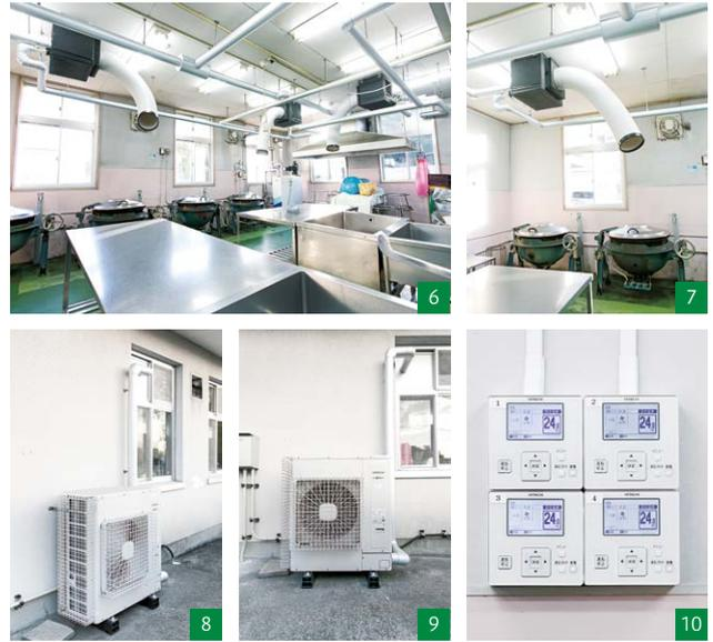
6 7 釜の前には2台の「クールショットマルチ」※1を設置。延長ダクトの風向きを調節することで、作業中の調理員すべての方に冷風や温風が届くよう配置している。8 9 室外ユニットの「フレックスマルチ-mini」には、児童への安全性に配慮して防護ネットを装着。10 温度調節だけではなく節電設定なども簡単に操作できる「多機能リモコン」を採用。
