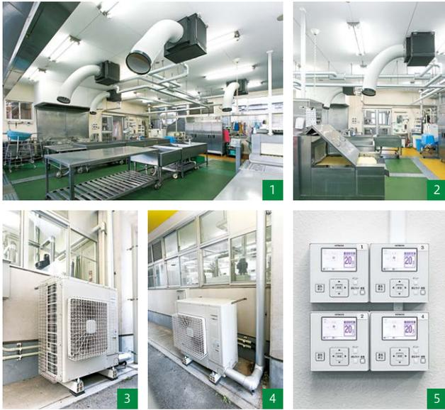
1 作業中のエリアだけに冷風や温風を送ることができる、個別運転が可能な「クールショットマルチ」※1を4台設置。2 洗浄機近くで作業をする調理員の方にピンポイントで冷風や温風が当たるよう、延長ダクト(オプション)を採用。3 4 室外ユニット1台で複数台の室内ユニットが個別運転できる「フレックスマルチ-mini」を設置。5 室内ユニットごとに個別の操作が可能な4台の「多機能リモコン」を1カ所に設置。
