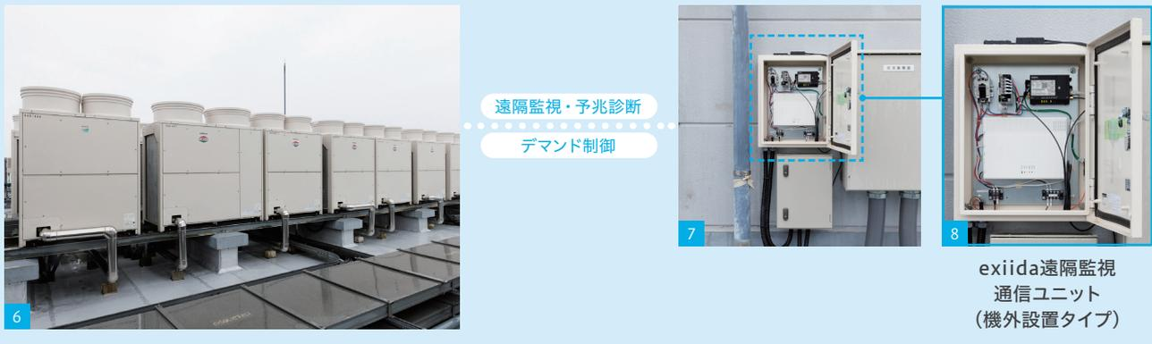
1 2 3 会議室と役員室には、「てんかせ4方向」を採用。4 5 専用Webサイトの管理画面にアクセスすることで、「exiida遠隔監視・デマンド制御ソリューション」では30分単位の電力量や目標デマンド値などのデータ、「exiida遠隔監視・予兆診断」では故障発生来歴や予兆診断月次報告書などが確認可能。パソコンだけではなくタブレットやスマートフォンからも手軽に閲覧できる。6 ビル用マルチエアコン「フレックスマルチ-R リニューアル型」を屋上に整然と配置。7 8 「exiida遠隔監視通信ユニット」(機外設置タイプ)は、屋上に設置。
