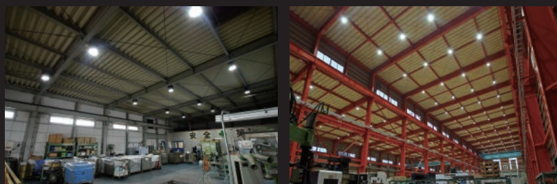
工場内や製品保管倉庫の天井照明
