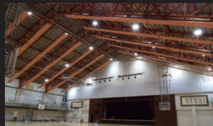
体育館など福利施設の天井照明
