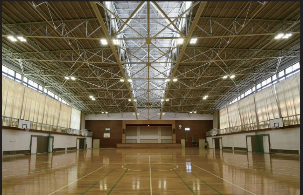
茨城キリスト教学園 体育館：茨城県日立市
