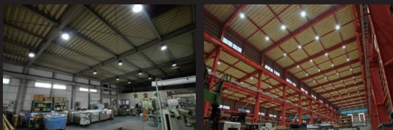
工場内や製品保管倉庫の天井照明
