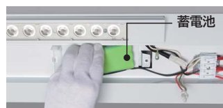
蓄電池を交換します。
