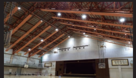
体育館など福利施設の天井照明
