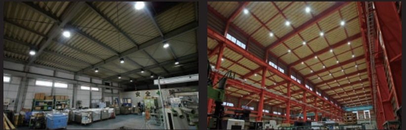
工場内や製品保管倉庫の天井照明
