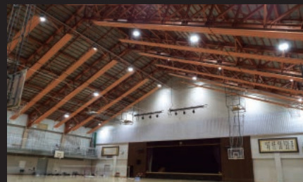
体育館など福利施設の天井照明
