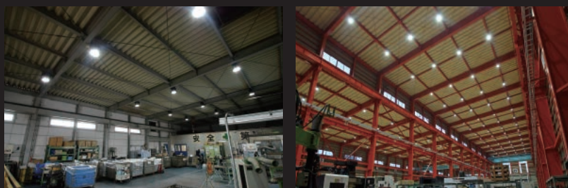
工場内や製品保管倉庫の天井照明
