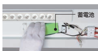
蓄電池を交換します。
