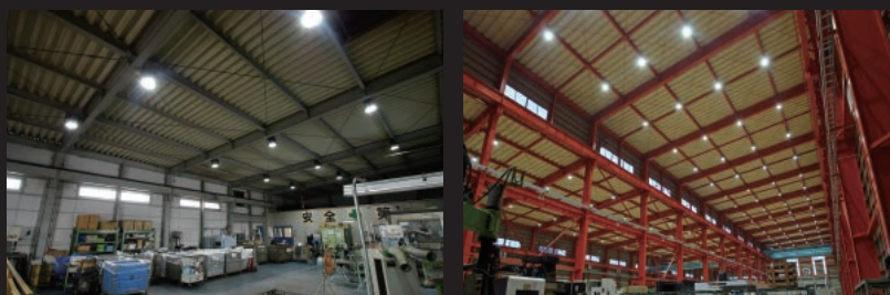
工場内や製品保管倉庫の天井照明
