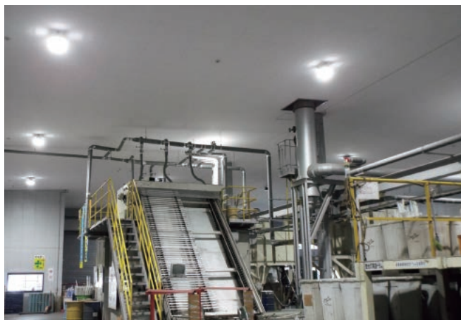
株式会社ウム・ヴェルト・ジャパン 本社/寄居工場 : 埼玉県大里郡寄居町
