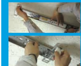
3 反射板を戻し直管形LEDランプを取り付ける
