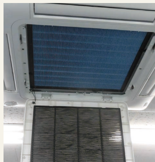
抗菌加工高性能フィルターをてんかせ4方向に取り付けた写真
